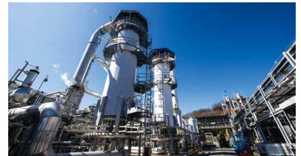
Hansol Chemical LNG Reformer for Hydrogen Production
